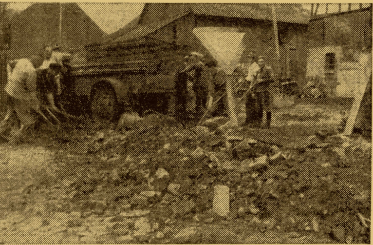
Auch in Bergheim hatten die Sturzfluten die Straßen des Dorfes völlig mit Schutt blockiert. In Gemeinschaftsarbeit wurde die Straße freigelegt.
