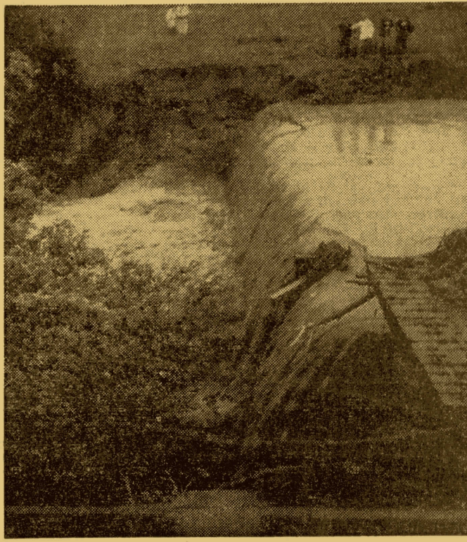
Innerhalb weniger Minuten wurde der rund zwei Meter hohe Bau aufbau des Eubach-Staus durch die tobenden Wassermassen weggerissen. Dieser zerborstene Staudamm war der Ausgangspunkt der Katastrophe.
